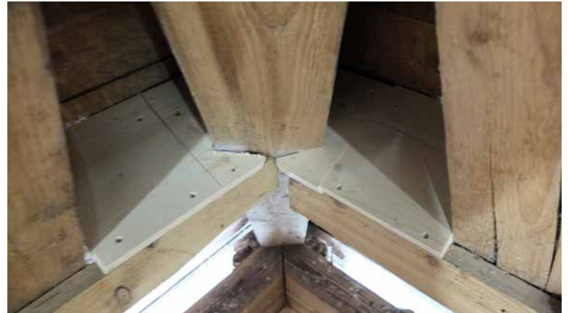
Das Anpassen und Einfügen der Deckbretter in der Ecke ist etwas kompliziert.
