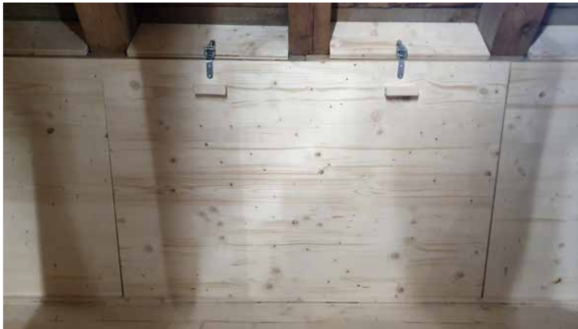
Die erste Stellwand mit Griffe und Kistenverschlüsse ist fertig.
