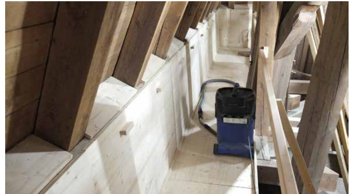
Noch fehlen die Kistenverschlüsse. Mit vorsichtiger Schätzung dürften in der neuen Einrichtung um die 70 bis 80 Brutpaare Platz finden. Die Endreinigung mit dem Staubsauger gehört bereits zum Finish.
