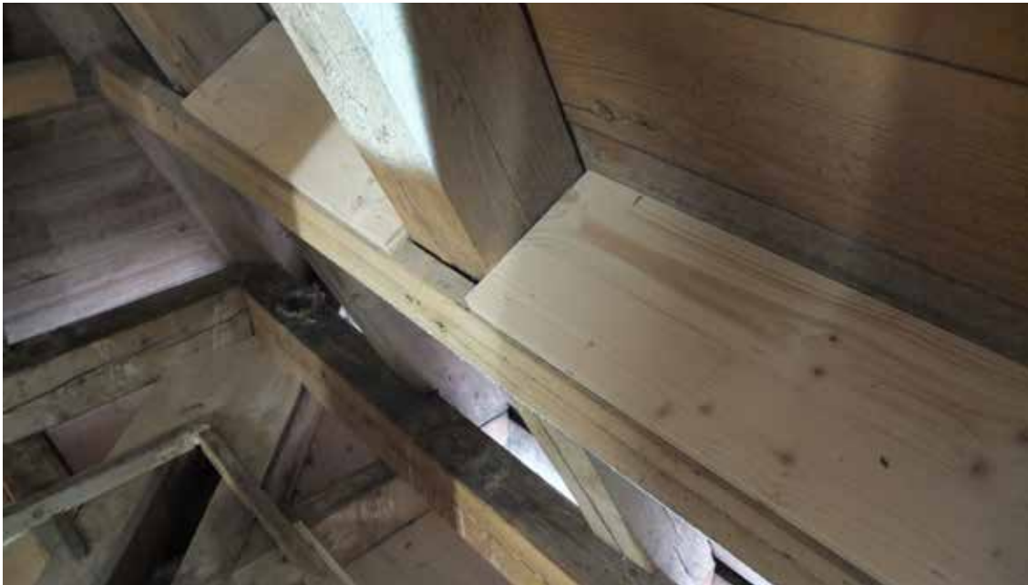
Neue Deckbretter, die nicht mehr zu öffnen sind, werden auf die obere bestehende Leiste getackert.
