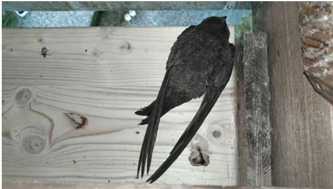
Bei letzten Arbeiten fliegt noch ein junger Alpensegler in die neue Brutnische und schaut uns entspannt zu. Die Alpensegler schaffen den schmalen Einflugschlitz und die neuen Bretter werden bereits wieder mit Vogelkot markiert.
