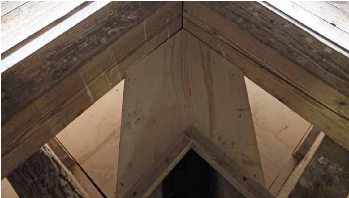
In den vier Ecken werden die schmalen Zwischenräume zwischen den Balken durch ein auf Mass gefertigtes Brett verschlossen. Die Segler können zwischen den Balken zukünftig nicht mehr brüten...
