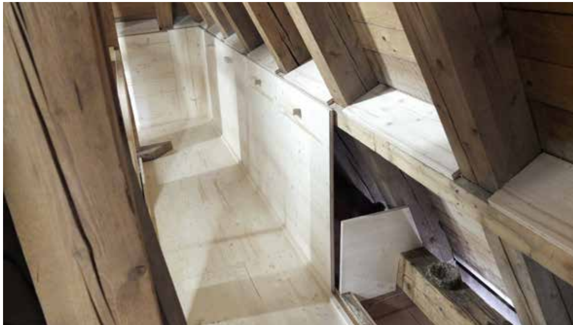
Die Stellwände werden mit einer Fussleiste eingeklemmt. Um in die Brutnische zu schauen, können diese leicht schräg gestellt werden. Mit den Handgriffen können die Stellwände einfach hinausgehoben werden.
