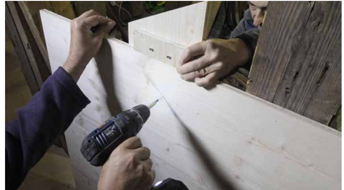
Mit einer selbstangefertigten Lehre werden alle Handgriffe präzise in die Mitte und auf stets gleicher Höhe der jeweiligen Stellwand geschraubt und geleimt.
