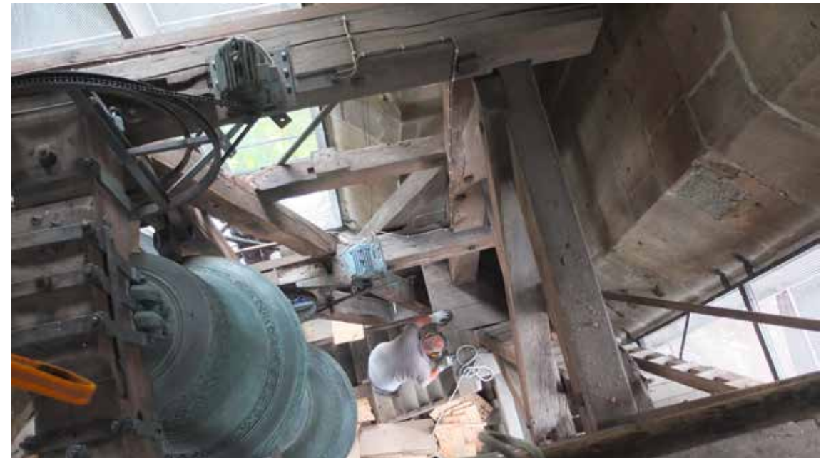
Insgesamt befördern, oder besser gesagt, werfen wir über 2,5 Tonnen Material aus dem oben sichtbaren Fenster in die 25 Meter tiefer liegende 6m 3 Mulde hinter der Kirche.
