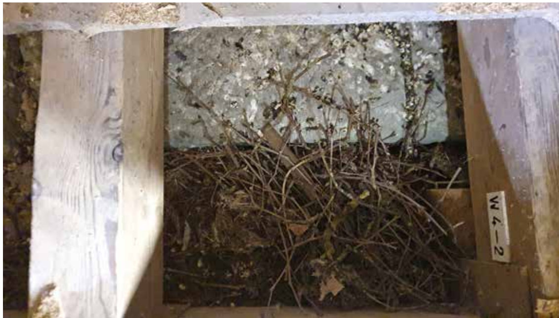
Die Sanierung erfolgt genau im richtigem Zeitpunkt. Die Dohlen haben sich durch den Einflugschlitz gezwängt und trugen viel Nistmaterial ein.
