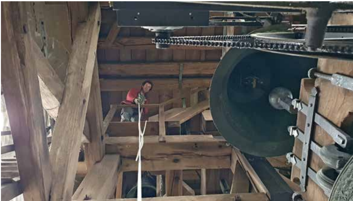
Tisu seilt mit Karabinerhaken zusammengeschnürte Materialpakete in den knapp sieben Meter weiter unten liegenden Glockenstuhl.
