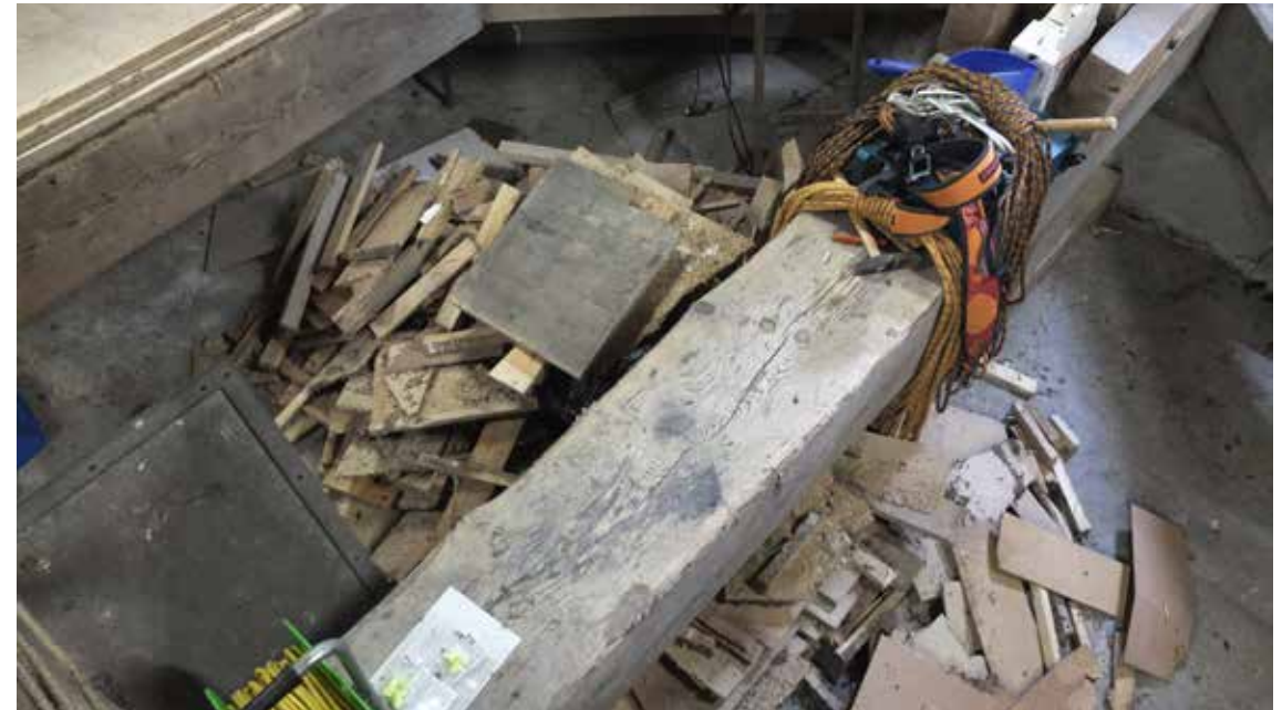
Nach den grossen Platten folgen immer kleinere Bauteile, welche wir in Ikeasäcke füllen und abseilen.
